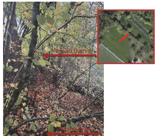
Abb. 31 Dammhöhe, Aufnahme vom Dammfuss
