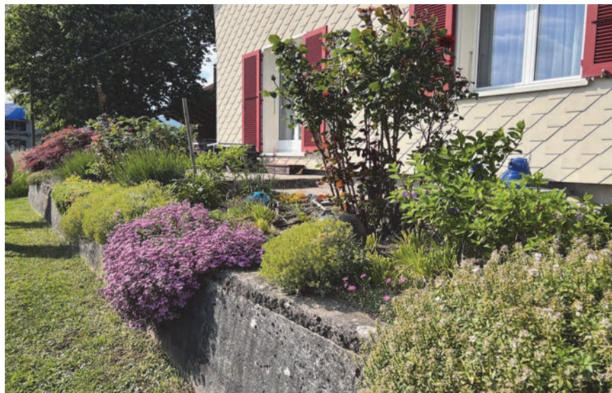
Abb. 23 Südfassade des Gebäudes Zelgli 7c mit gemauerter Abgrenzung zur Landwirtschaftsfläche
